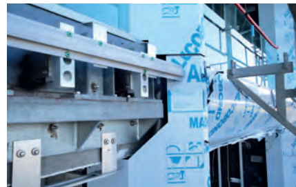
Gebäudefront mit Stahl und Glasbrüstung
