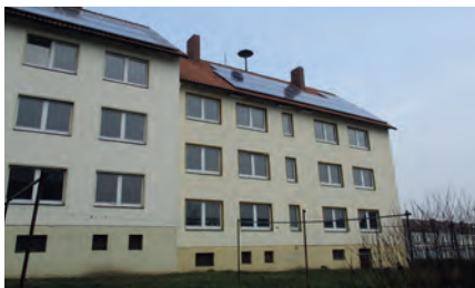
vor Sanierung, Elze, Heinestraße 1
