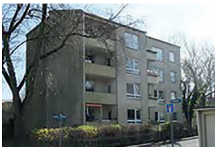
vor Sanierung, Bochum, Diemelstr. 24
